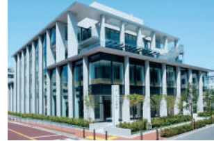
2022年9月に開館した神奈川県立図書館本館
